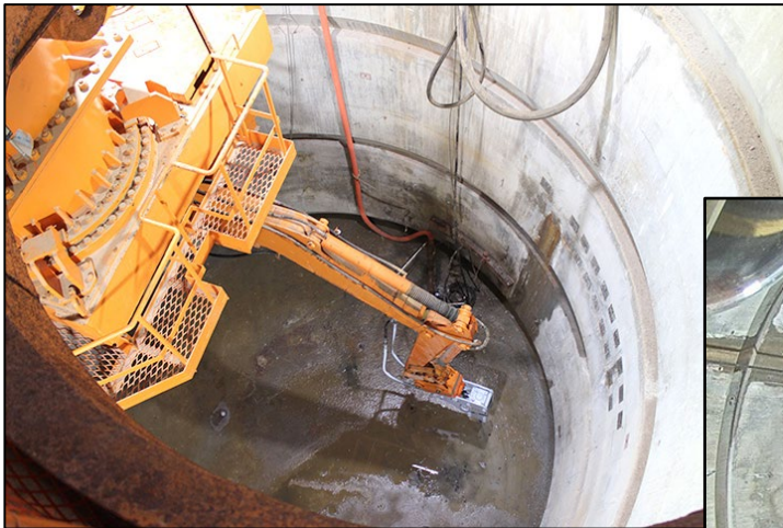
東立坑掘削開始時の状況 (380m底盤)
