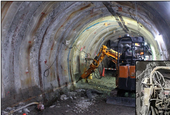
試験坑道6掘削開始時の状況
