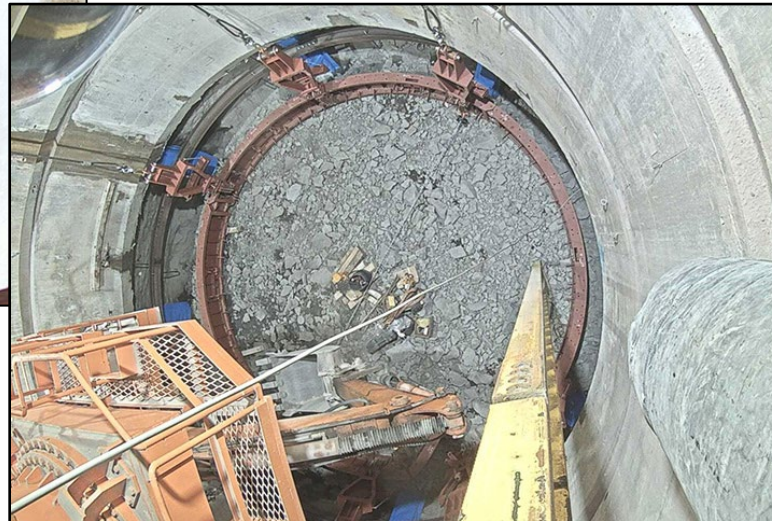
東立坑の掘削状況(R5.10.17) (型枠(センター)の設置)
